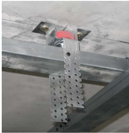
Монтаж каркаса звукоизоляционного подвесного потолка при помощи креплений Vibrofix® PU
