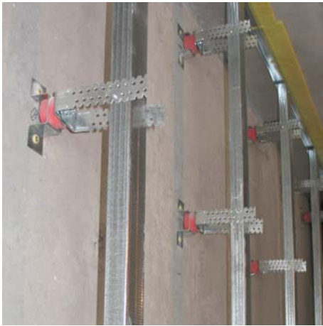
Монтаж каркаса звукоизолирующей облицовки стены при помощи креплений Vibrofix® CD
